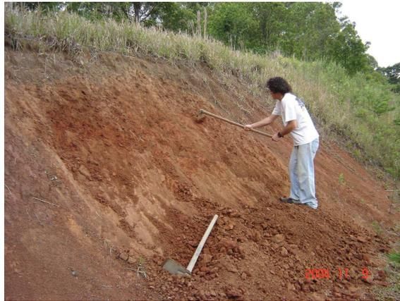
**Figura 04: Extração de argila em talude no IPAT**
